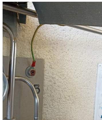
Figure 16 : Tête de l'installation de gaz raccordée à la terre
