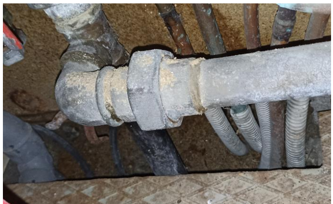
Figure 11 : Arrivée d'eau bâtiment 2 et bâtiment 1
