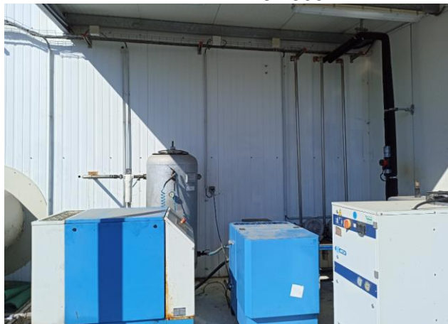
Figure 15: Air Comprimé à raccorder à la terre
