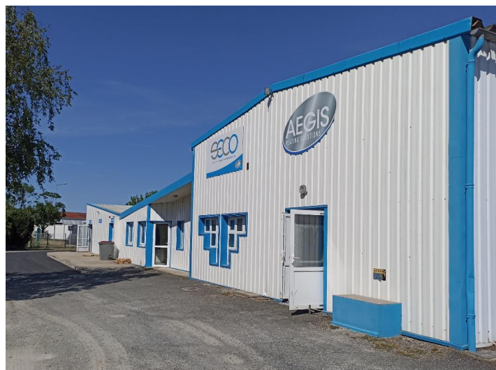
Figure 6 : Façade Sud - Bâtiment 1
