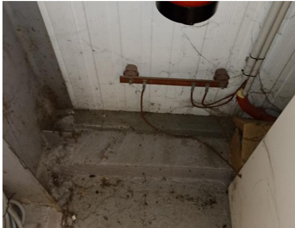
Figure 10 : Mise à la terre charpente bâtiment 2 et Barette de terre Local Téléphonique bâtiment 1.
