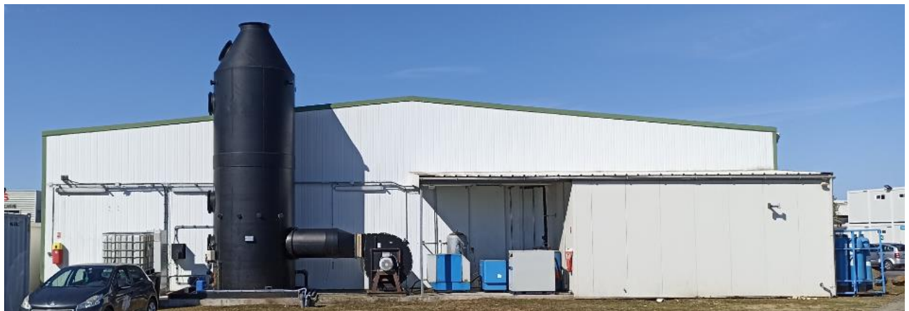
Figure 5 : Façade Est - Bâtiment n° 2
