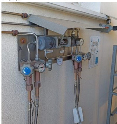
Figure 16 : Tête de l'installation de gaz raccordée à la terre
