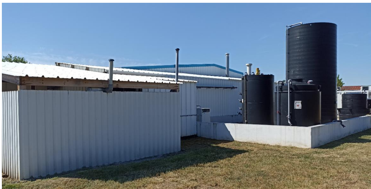
Figure 7 : Façade Nord - Bâtiment 1
